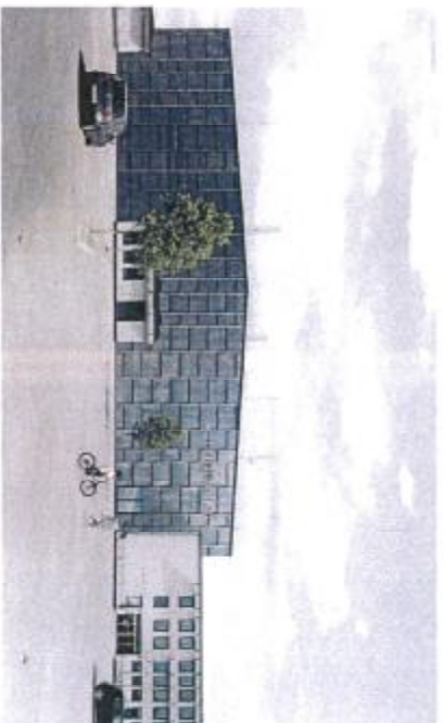
SYDFACADE Facaden beklædes med en mørk cementlisterplade
