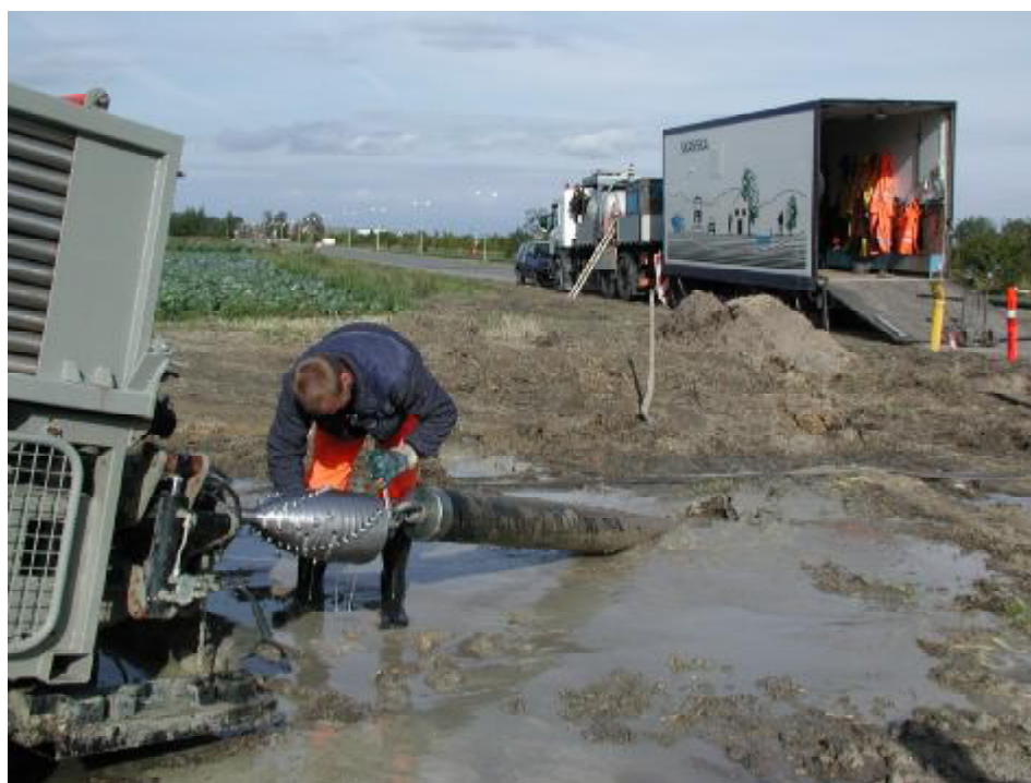
Etablering af ny spildevandstrykledning i/ved Kalvebodvej. Udført ved styret underboring.
