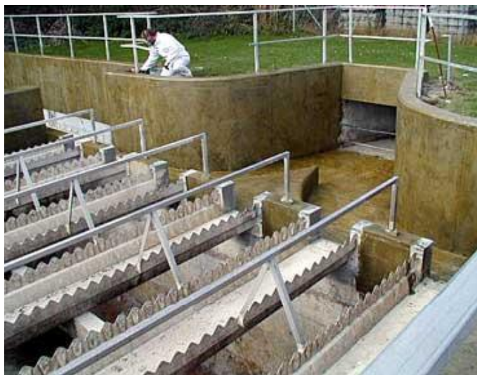
Overfladebehandling af betonkonstruktion på renselanlægget
