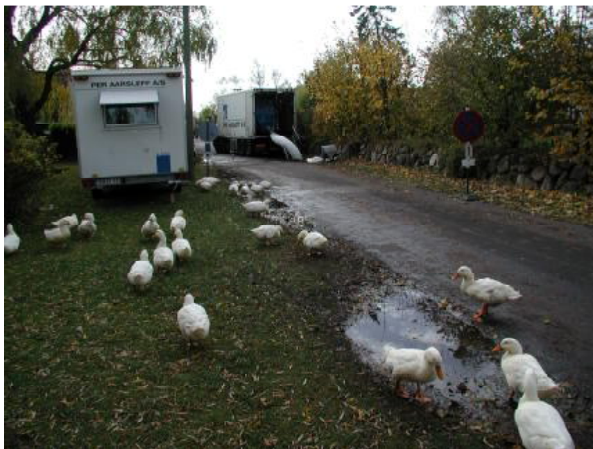
Kloakreivering af eksisterende ledninger i St. Magleby
