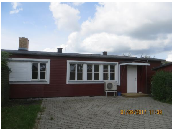
Foto 1: Møllevvej 9A, facade
