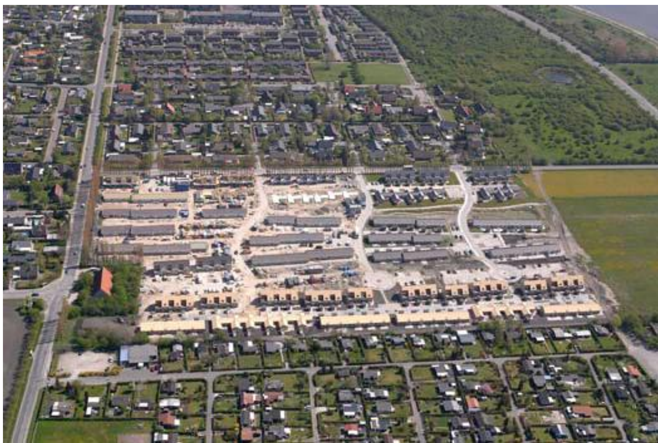
Boligbebyggelsen mellem Store Magleby Strandvej og Haveforeningen Søndergården under opførelse
