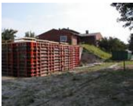
Store Magleby Vandværk med opførelse af en ny rentvandstank
