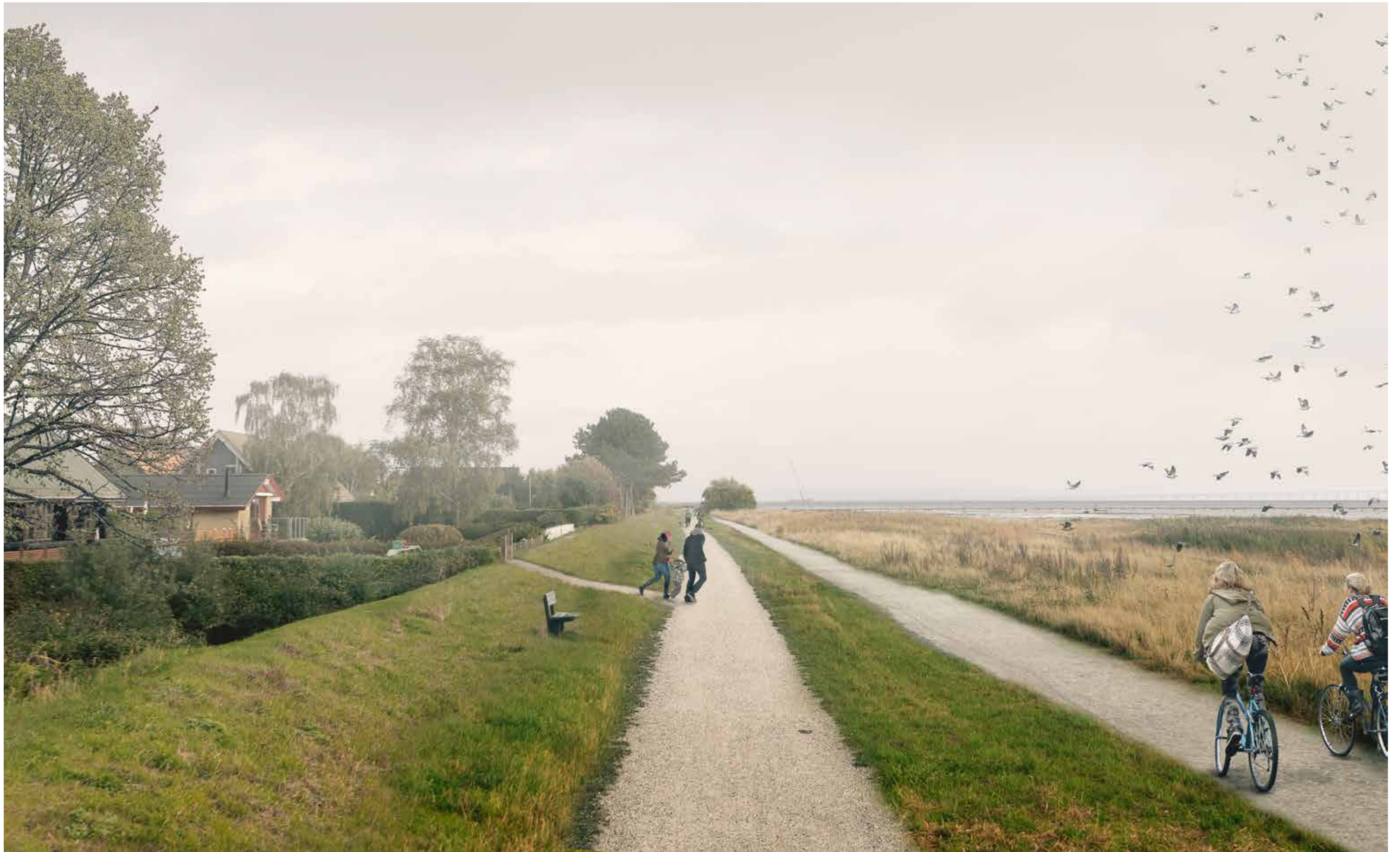
Det eksisterende dige ved Søvang omprofileres med en ny digekrone, som man ikke går på, og en øvre gangsti på grus og en nedre cykelsti på asfalt.
