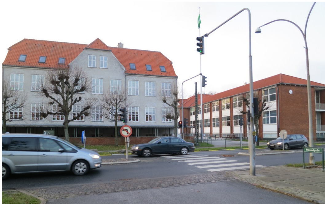
Foto 1: Udkørsel fra Strandgade sker udenfor signalreguleringen. Dette fører til konflikter med fodgængere i fodgængerfeltet.
