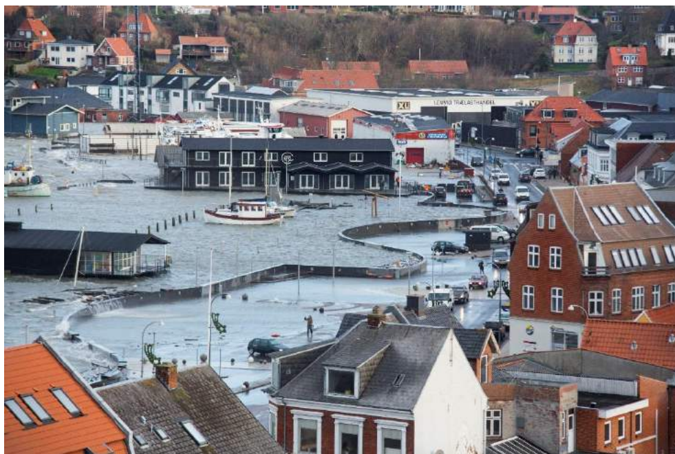
Figur 3-1 Stormflodssikring i Lemvig.
