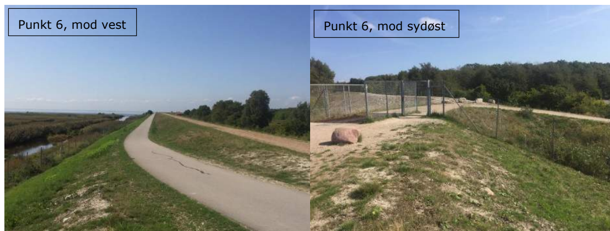
Figur 7-9 Afslutningen af Vestamagerdiget. Hvor Ullerupddiget nu er næsten færdigetableret.
