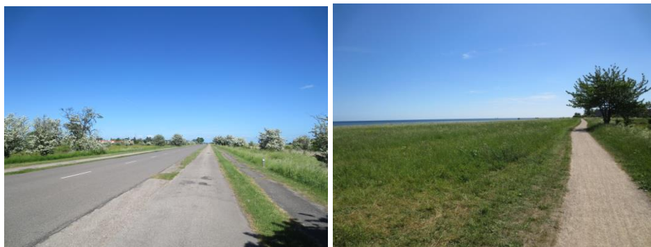
Figur 4.7: Venstre: Søndre Strandvej. Cyklesti og fortov kan hæves og virke som højvandssikring. Højre: Dige med sti ved Bachmanns minde syd for byen
