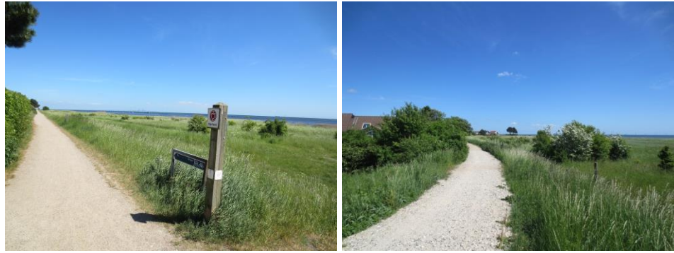
Figur 4.9: Venstre: Dige med sti ud for Søvang. Højre: Dige i den sydlige del af Søvang forstærket efter den seneste stormflod.
