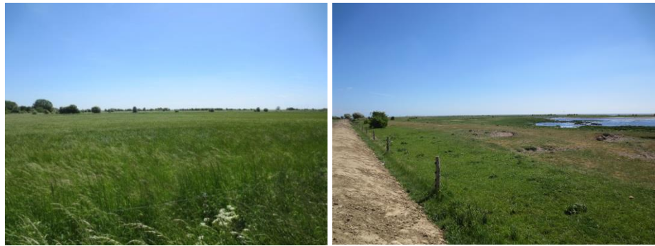
Figur 4.11: Lavtliggende dyrkede og naturområder på delstrækning Søvang-Kongelunden. På det højre billede ses mindre digeforstærkning ud for TAMU-centret
