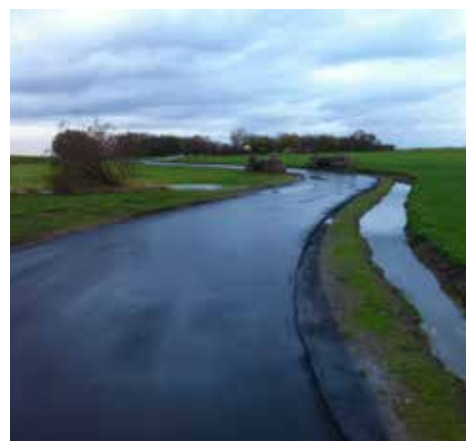
▲ Nye regnvandsgrøfter langs Wiedersvej ved Batterihøj
