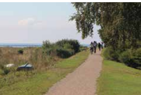
Diget ud for Søvang, der er anlagt med en topkote på ca. 2,0 m. ▲
