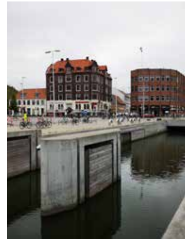
Slusen i Aarhus Å lige inden mødet med havnebassinet. Ved siden af, er der etableret underjordisk overløbsbassin. Foto: Nikolaj Knudsen.
