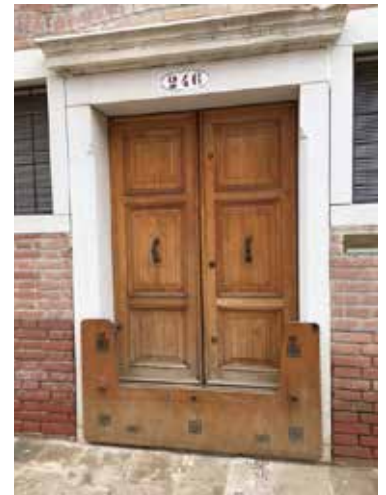
Skotter som i materialer og forarbejdning er tilpasset historisk bygning, Venedig 2019. Foto: Kari Moseng
