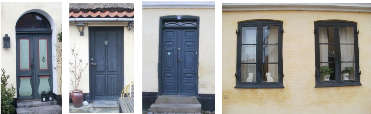
Døre og vinduer.
