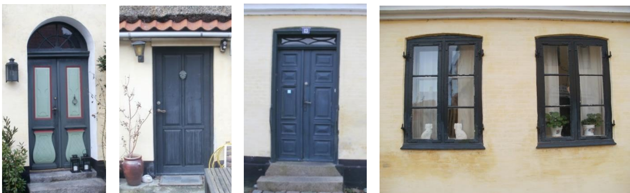
Døre og vinduer.
