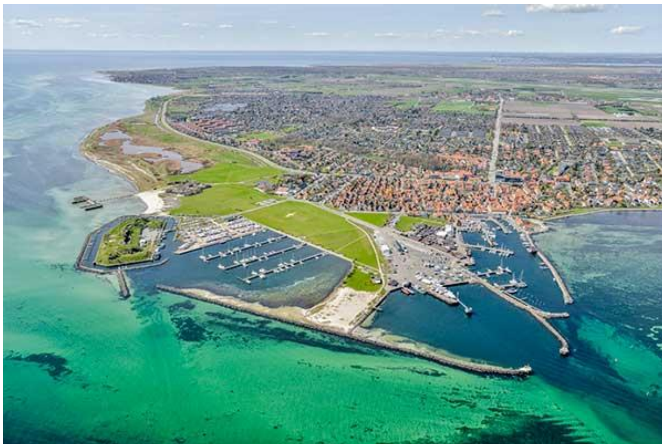
Luftfoto af Dragør i dag. Forrest de to nye færebassiner. Bagest den gamle havn og den gamle by. Til venstre Dragørfortet og strandengene.
