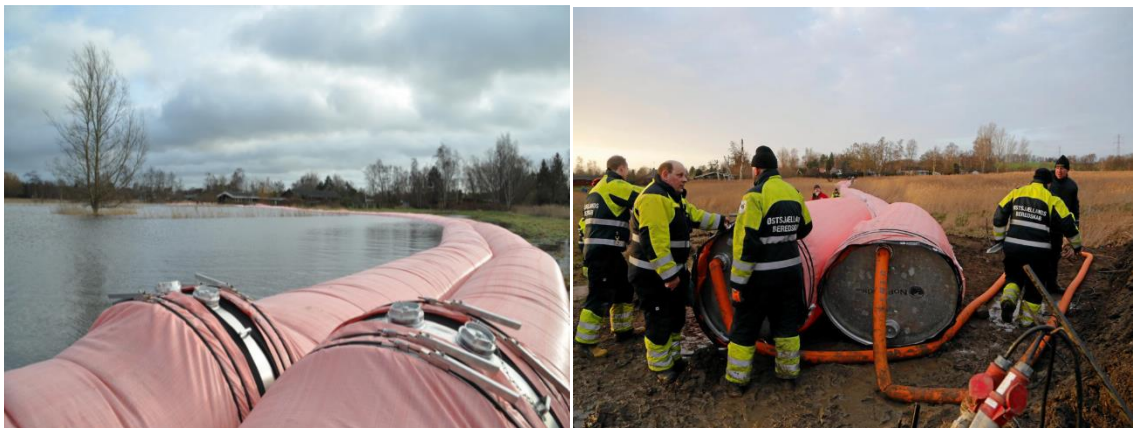
Figur 8-1 Eksempler på WaterTubes. (kilde: https://nofloods.com/inflatable-flood-barrier-pro/ )
