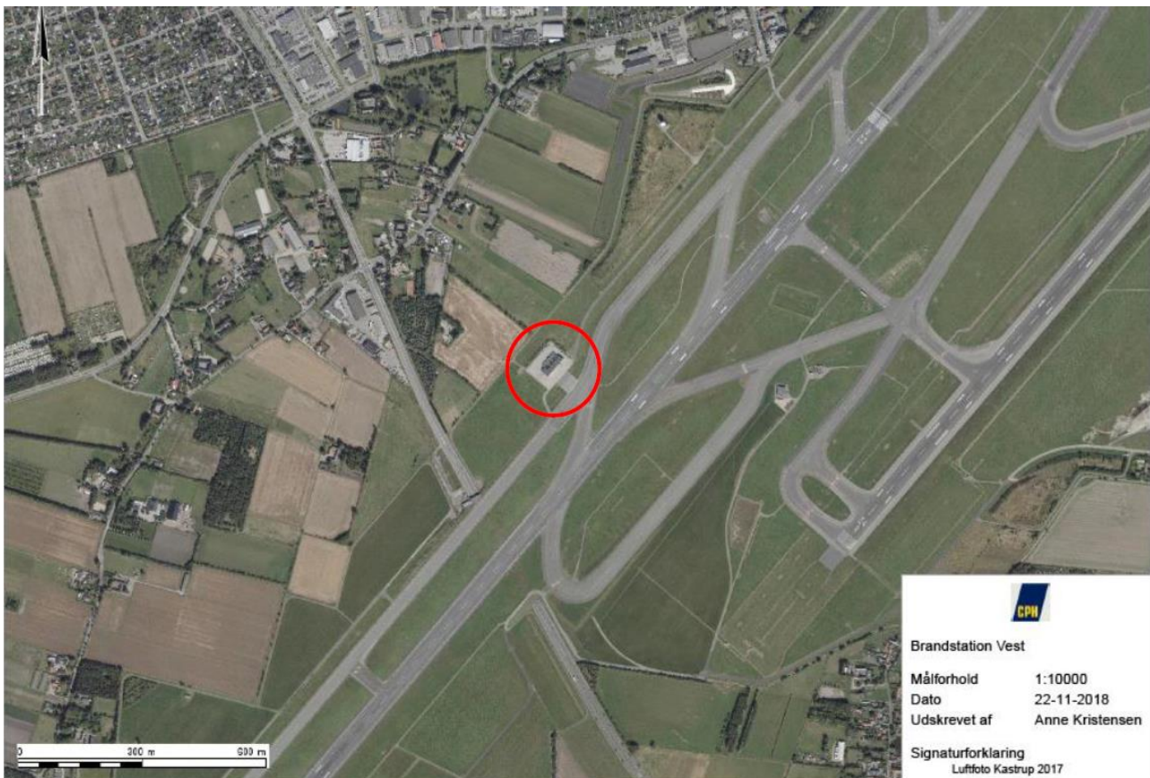
Figur 1.1 Brandstation Vest er beliggende NØ for Engelsbøjs tunnelen.
