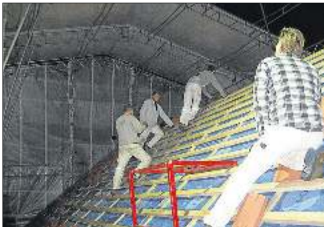
Tømrerne i fuld gang med at lægge af efter at det de skæve spær er rettet op
